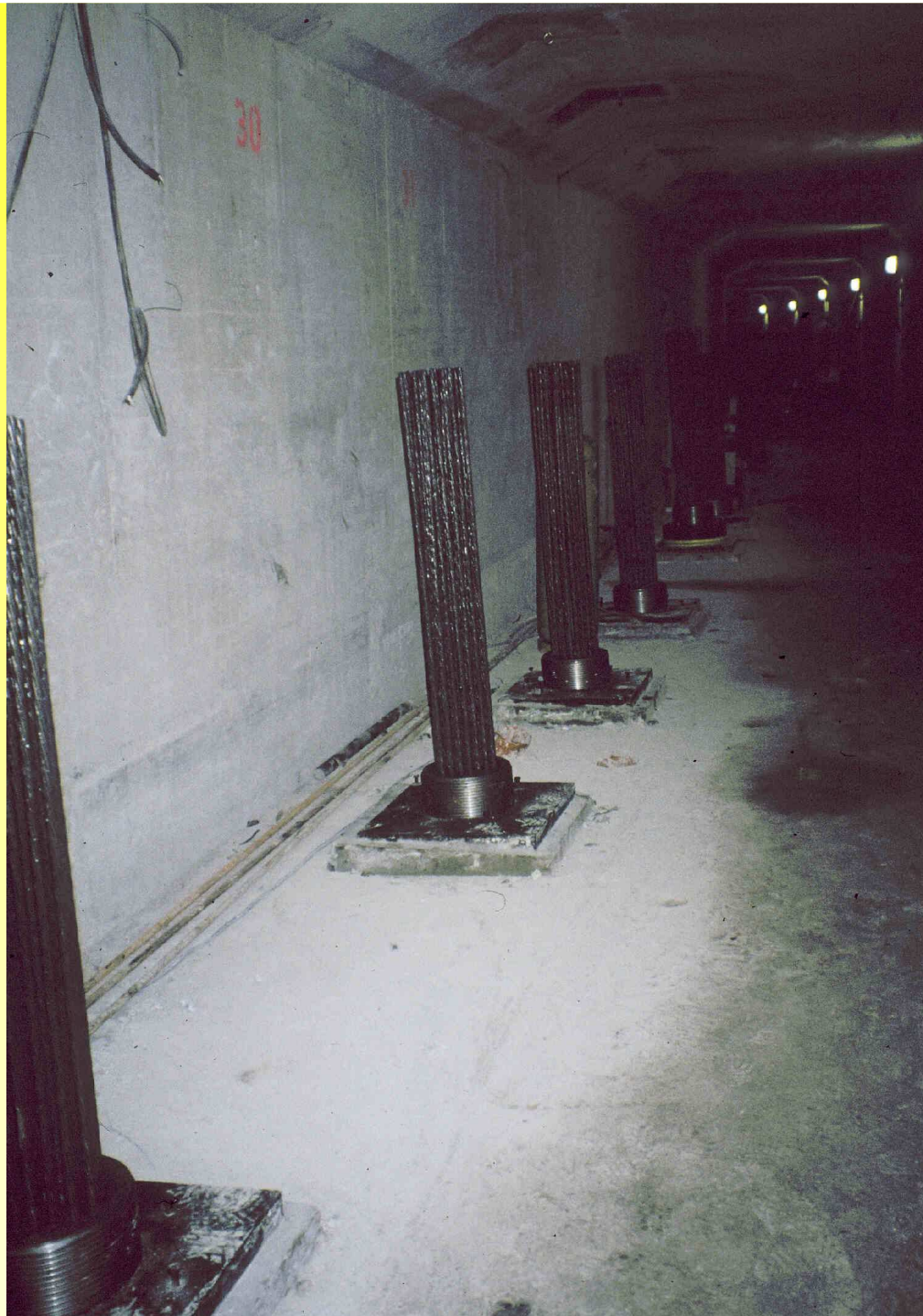
Köpfe der Vorspannanker im Stollen an der Krone der Edermauer
